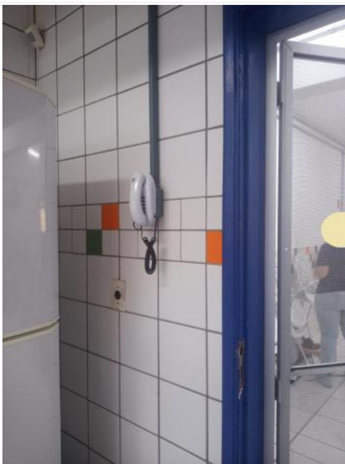
CEDIN Marilda Ferreira de Brito Pereira - Instalação dos interfones
