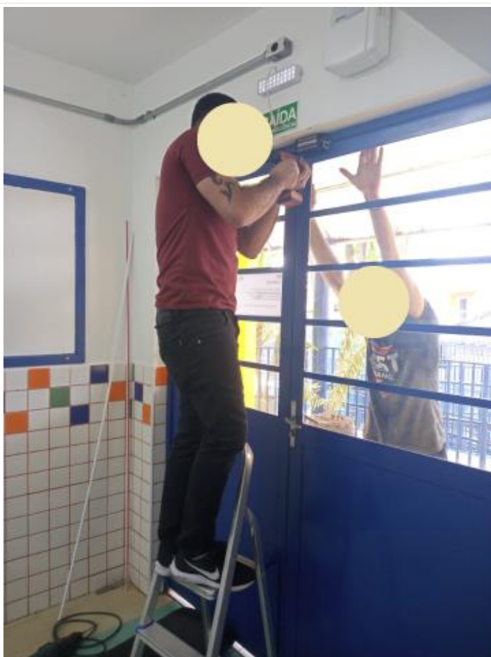
CEDIN Marilda Ferreira de Brito Pereira - Instalação do sistema magnético na porta de entrada
